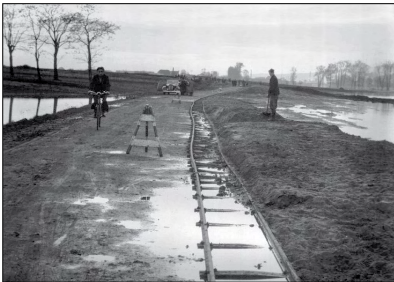
Stavba silnice Litoměřice – Mlékojedy – Prosmuky (SOKA Litoměřice)
