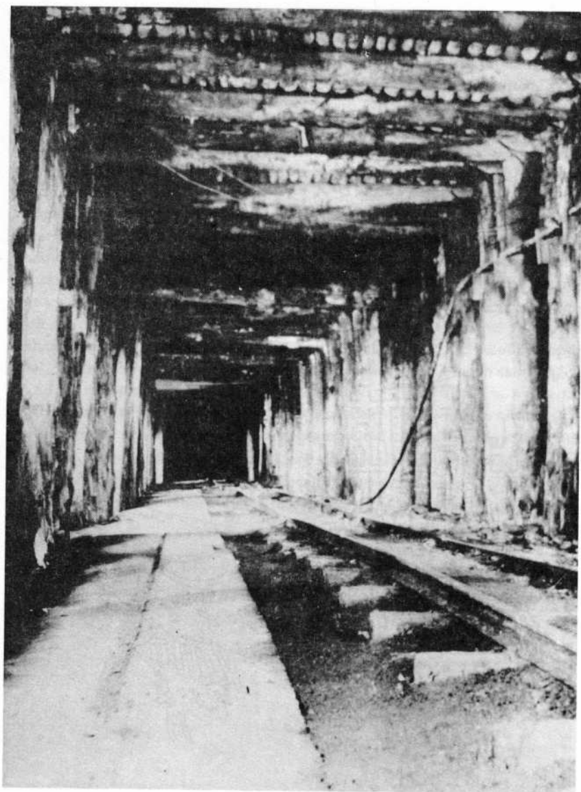
Pohled do jedné z chodeb podzemní továrny.
