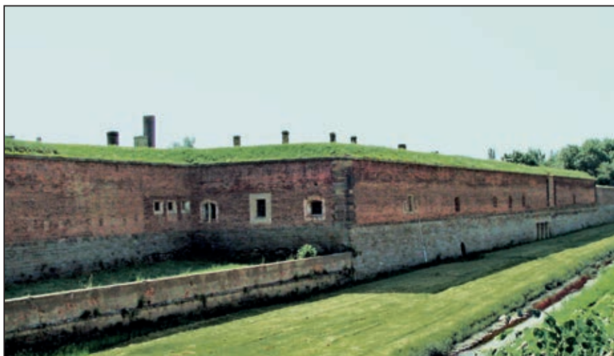
(3) Pohled na šíjovou část Malé pevnosti, kde jsou patrna šíjová kasárna se střílnami, které měly sloužit k obraně týlu objektu. Umístění šíjových kasáren je jeden z největších rozdílů mezi projektem korunní hradby a realizovaným provedením Malé pevnosti
